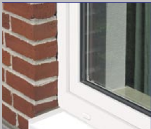
Auch nach elf Jahren verfügen die weißen acrylcolor-Fenster noch über eine gepflegte Oberfläche.
