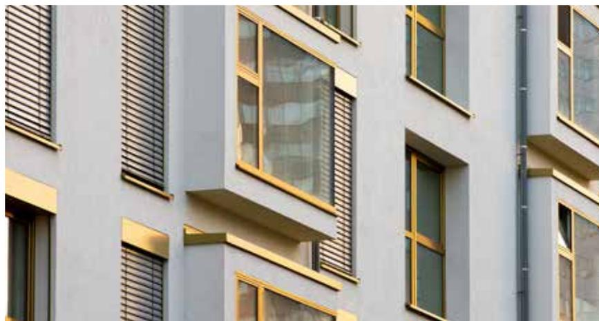
Os perfis GEALAN-acrylcolor® coloridos são produzidos desde 1980 através de processos de coextrusão. A GEALAN define novos padrões com esta tecnologia de acabamento, uma vez que se distingue totalmente dos restantes processos de coloração: no processo de coextrusão, o suporte de base em PVC branco e a camada de alta qualidade em vidro acrílico são unidos de forma inseparável.
