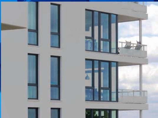
Ventanas con junta central fija del sistema S 9000 plus ofrecen un plus en
