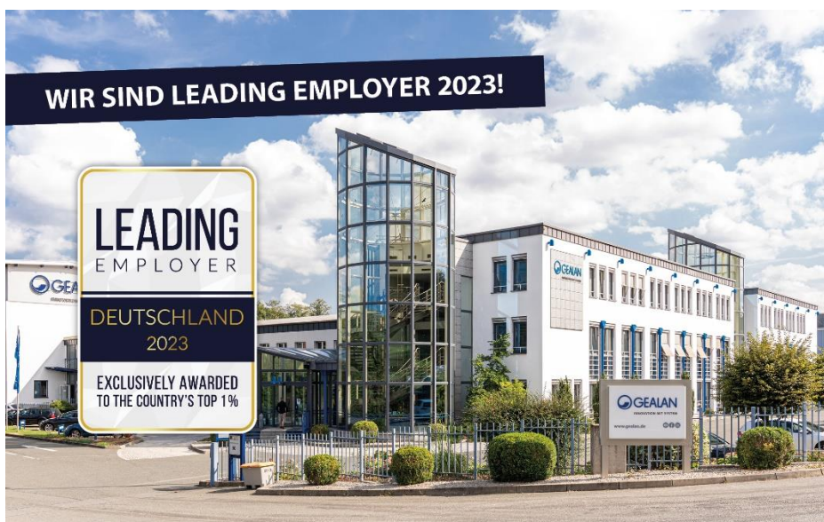
Der GEALAN-Hauptsitz im oberfränkischen Oberkotzau. (Foto: GEALAN)
